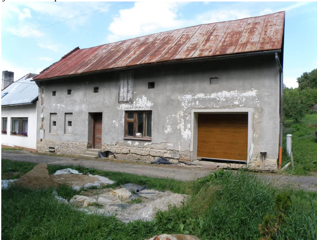
Současný vzhled domu č. p. 9.
